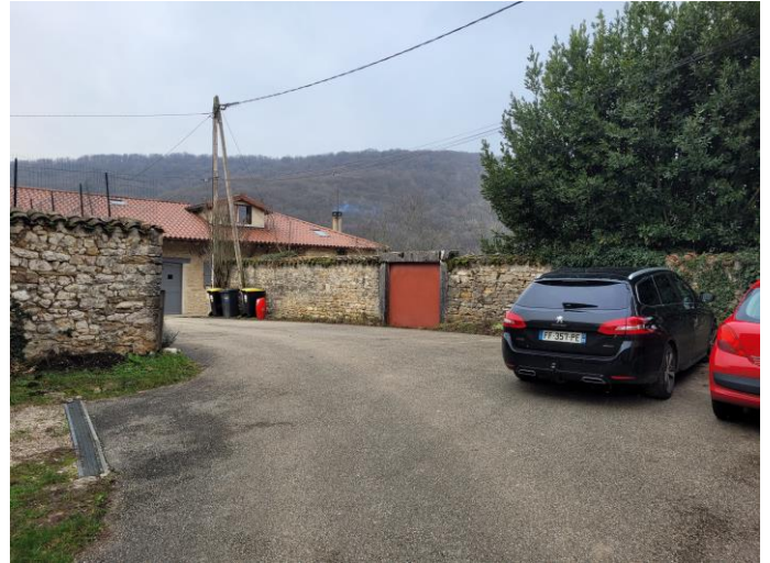
Vue sur le mur d'enceinte Nord du site, depuis la rue de Boisserolles.
